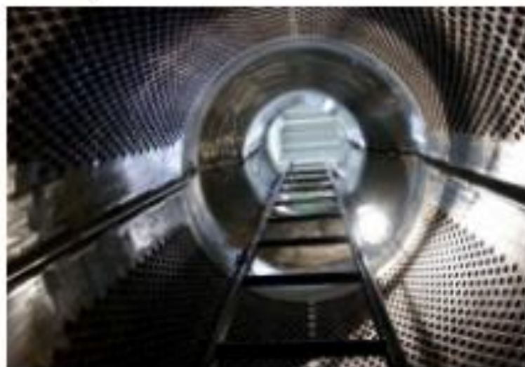
Gőzfejlesztő primerköri kollektor beltről a hűtendő csövekkel (5536 db)
